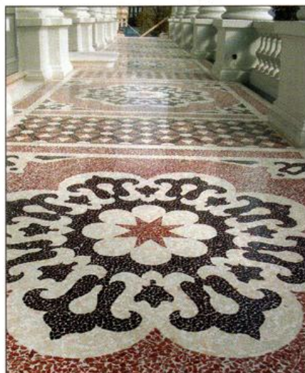
Der neu verlegte Terrazzoboden im Palais Coburg. Infos unter www.mosaiken.at
