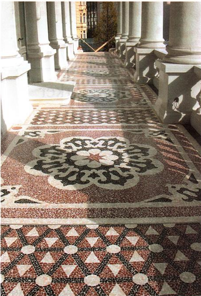
Palais Coburg, Wien: 800 m 2 Mosaikböden nach altem Muster verlegt.
