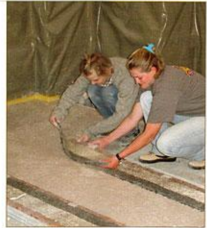
Verlegen der Einzelornamente
